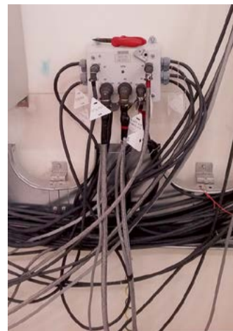
Вот такой «паучок» скоро превратится в красоту (сооружение СГК, помещение 2021)
