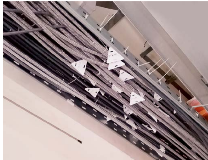
В процессе монтажа обязательно выполняется требование по биркованию кабеля
