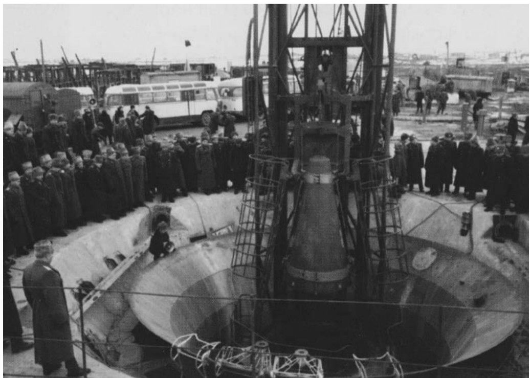
Загрузка ракеты-носителя в ШПУ
