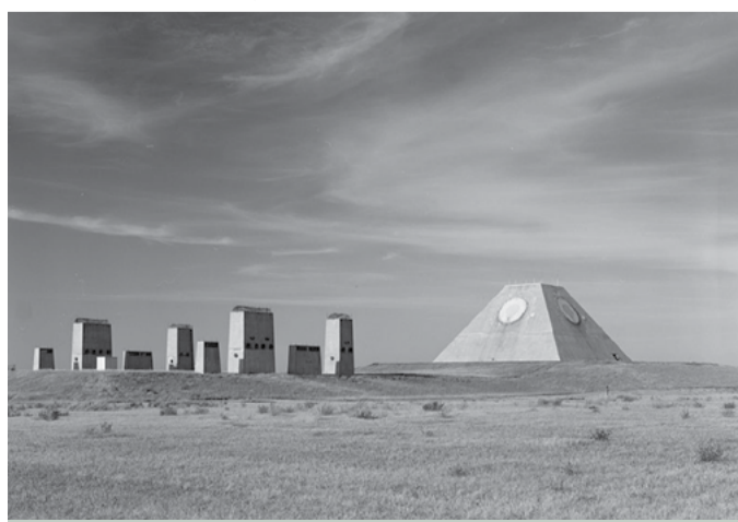
Американская противоракетная система Sentinel/Safeguard на базе в Северной Дакоте, аналогичная по архитектуре нашей А-135. Слева от радара — выхлопные трубы генераторной станции
