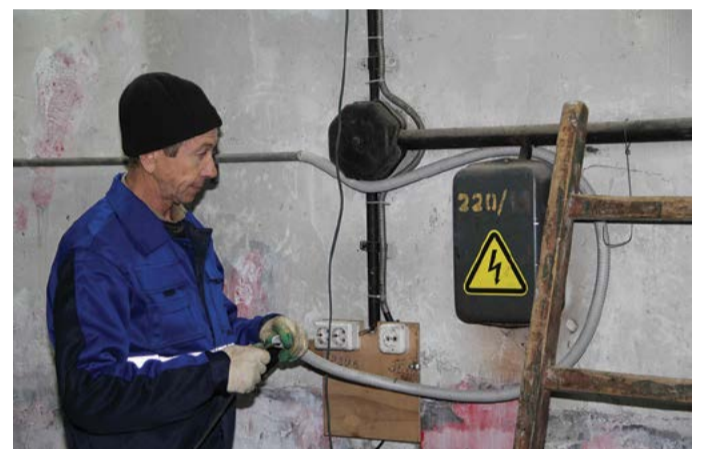
Электромонтажный участок. Резка кабеля для подсоединения к соединительному ящику. Электромонтажник-бригадир Иванов А. В.
