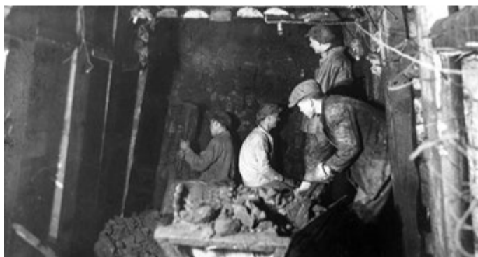
Проходка тоннеля 1-й очереди московского метро
